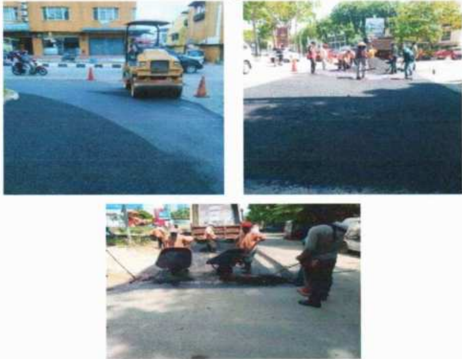
Gambar Pemeliharaan rutin jalan di Kota Batam
